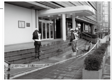
滑り止め加工の施工の様子
